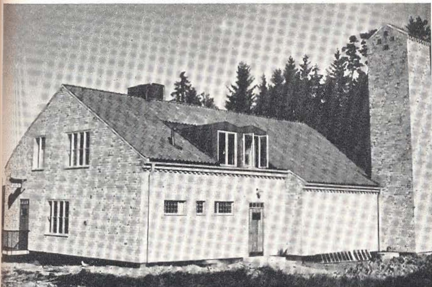
Polis- och brandstationen vid Sturevägen i Jakobsberg. Byggnaden invigdes 1946. Polisstationen har sin ingång längst t. v. på bilden.
