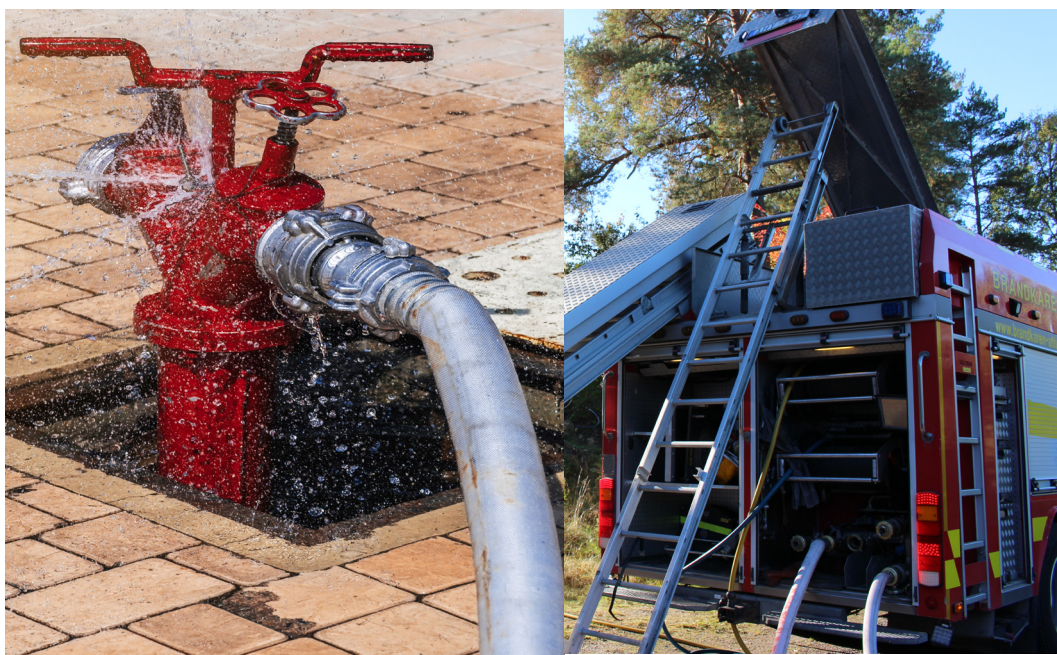
Figur 4 och 5. Exempel på brandvattenförsörjning med konventionellt system
