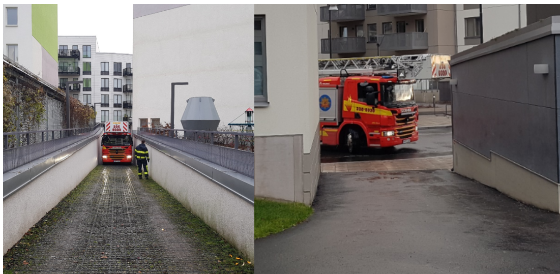
Figur 5: Bild till vänster visar en räddningsväg som är projekterad enligt de minsta måtten. Bild till höger visar en räddningsväg som inte går att köra in på då svänggradien är för kort från den kommunala gatan.
