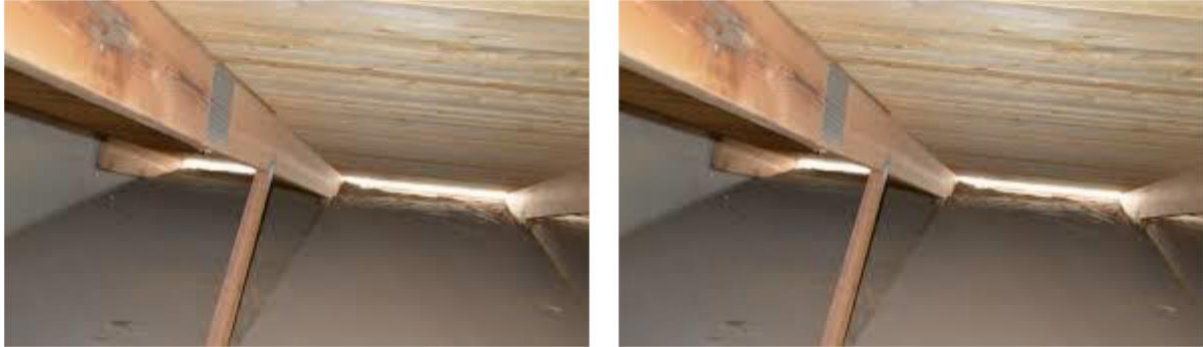
Figur 2 - Exempel på hur en ventilerad takfot kan se ut både inifrån och utifrån. Bilderna är från räddningstjänsten i Norrtälje kommun.
