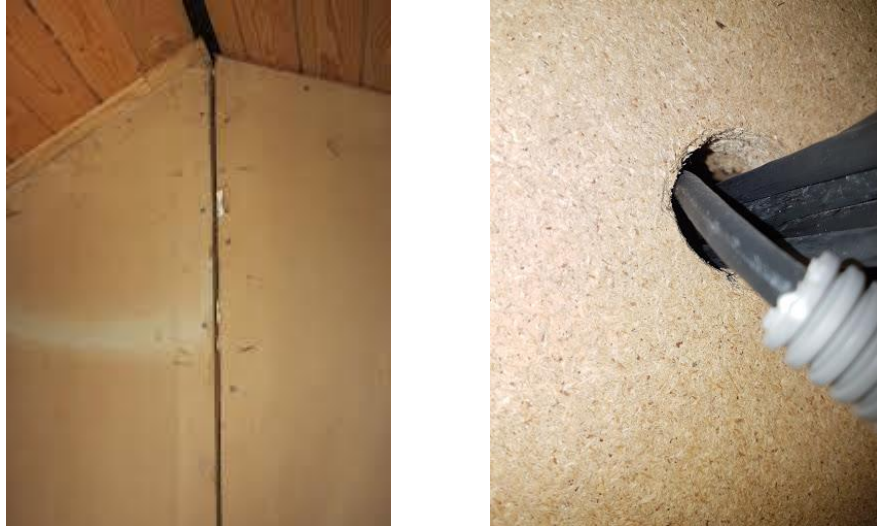
Figur 4 - Exempel på otättheter i avskiljande vägg. Bilderna är från Räddningstjänsten Medelpad och Räddningstjänsten Syd.
