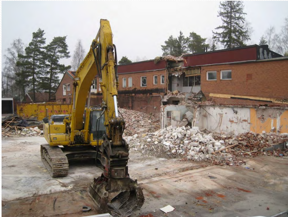
Rivning av brandstationen 2006
