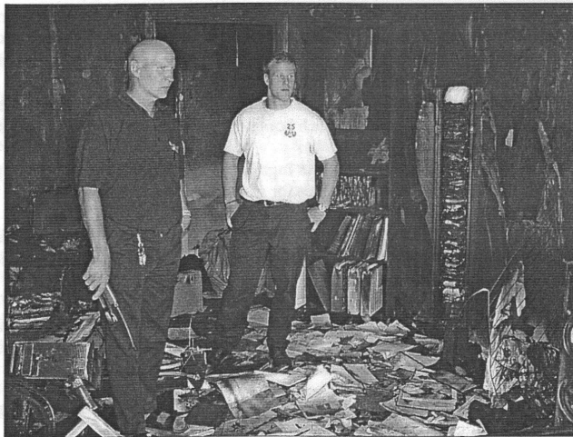
Stefan Ramström och Henrik Fredén begrundar de omfattande skadorna i det rum där branden startade.
